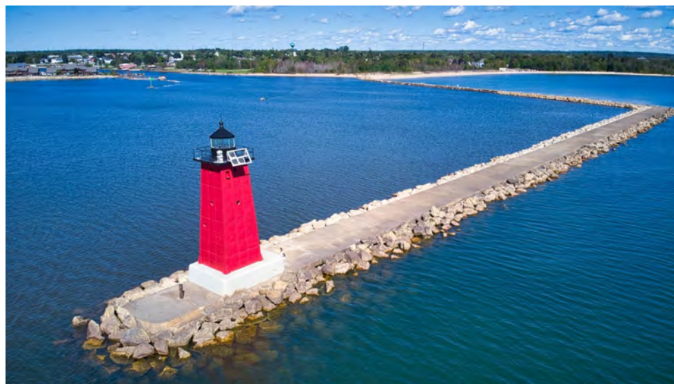
Mainstique East Breakwater, MI – Photo: Lew Folkerth
